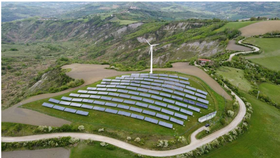
Sotto: Foto aerea impianti ISA
